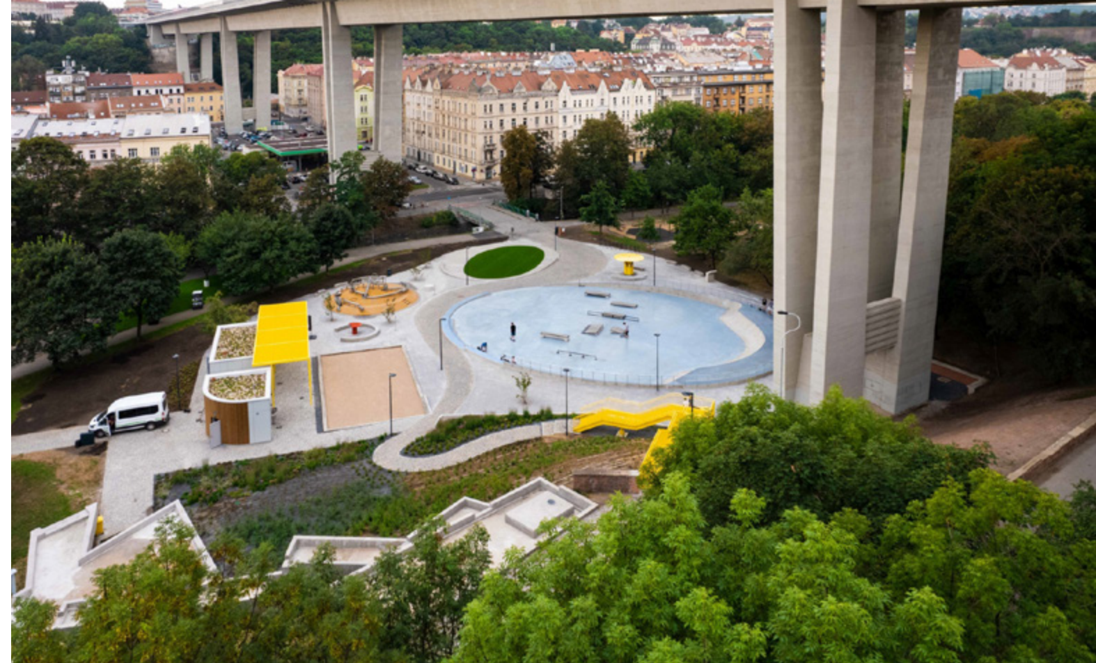
Areál Jammertal pod Nuselským mostem
