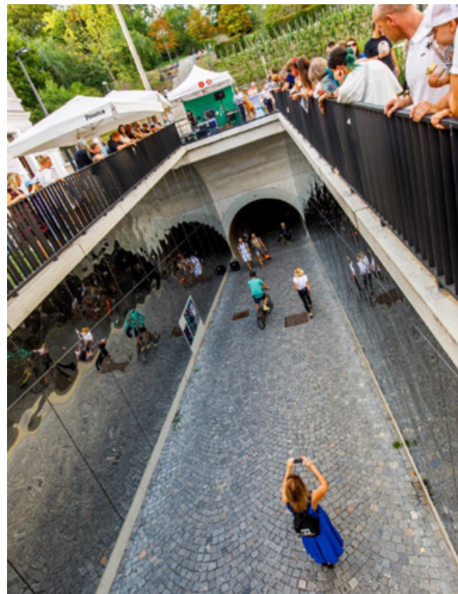
Rekonstrukce vjezdu do tunelu pod kopcem Vítkov
